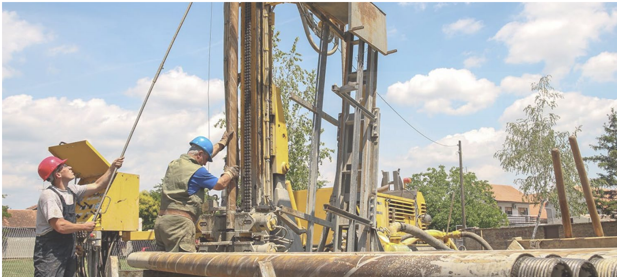
Slika 11: Pilotna geotermična elektrarna na obstoječi plinski vrtini Pg-8
