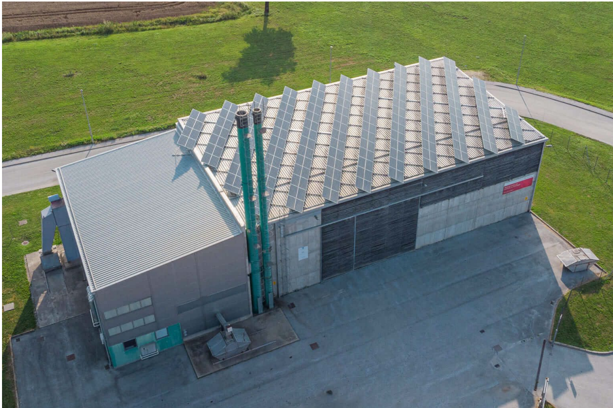
Slika 10: Sistem daljinskega ogrevanja Lenart
